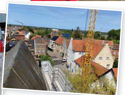
▲ Werken aan het dak van de bib
